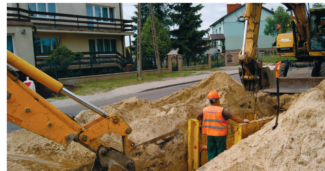
Kanalizacja będzie budowana na trzech ulicach
