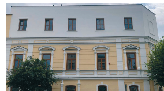
Budynek muzeum i biblioteki zyskał nową elewację
