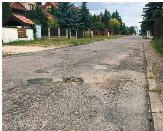
Ulica Powstańców Wielkopolskich zostanie wyremontowana
