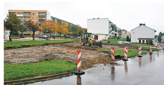
Prace częściowo już wykonano
