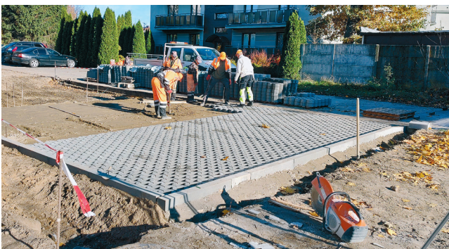
Prace prowadziło MPDM
